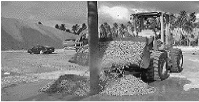
Bild 2. Einbau der Schotterssäulen Fig. 2. Installation of the stone columns
