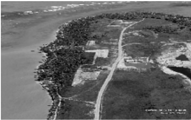
Bild 1. Luftbild des Baugeländes Fig. 1. Aerial view of the site
